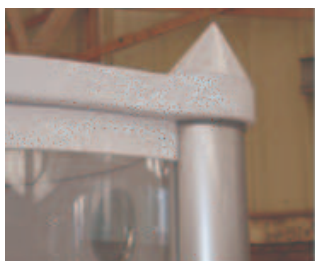
UNION DE PILARES Y PERFILES CURVOS
