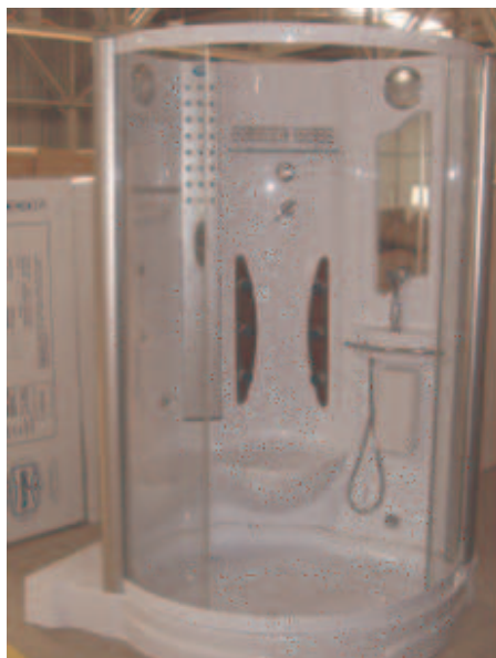
INSTALACION DEL MARCO Y VIDRIOS EN EL FRENTE DEL BOX
