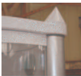
Unión de pilares y perfiles curvos.
