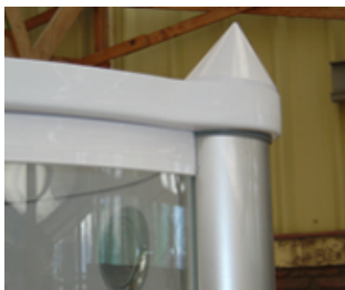
UNION DE PILARES Y PERFILES CURVOS
